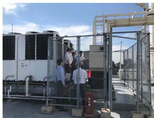
予備発電機の手動運転方法確認
