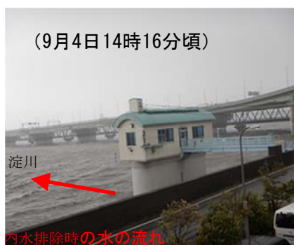
淀川への排水（取水口部）
